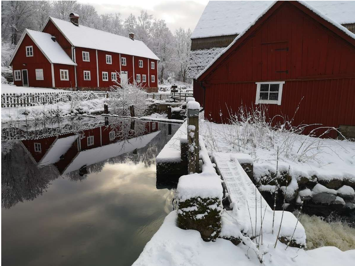
Bild: Utloppet vid Bökestads mölla med utskov till höger och luckor rakt fram
