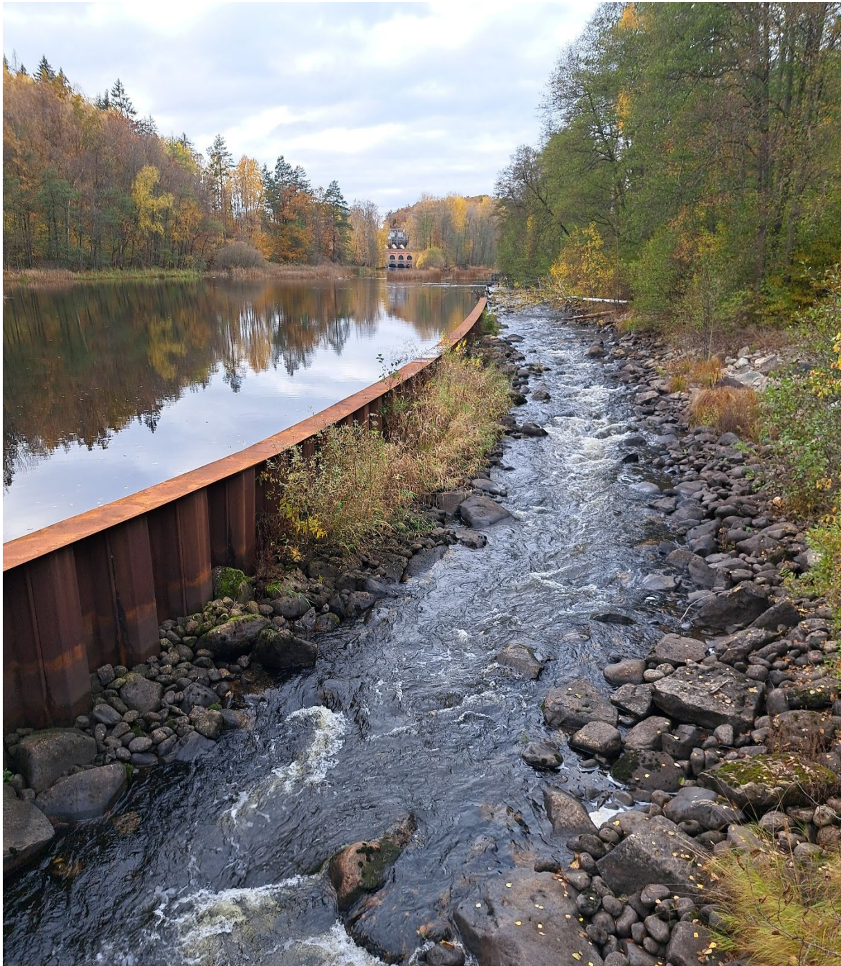
Figur 3. Inlöp vid regleringsdammen till Hemsjö nedre kraftverk. I bakgrunden syns Hemsjö övre kraftverk.
