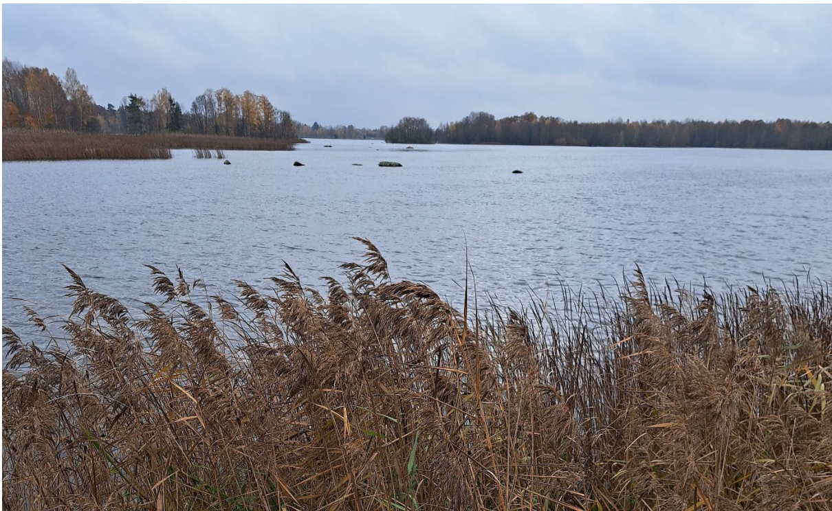
Figur 25. Dämningsområdet till Granö kraftverk sett norrifrån väg 648 i Ryd.
