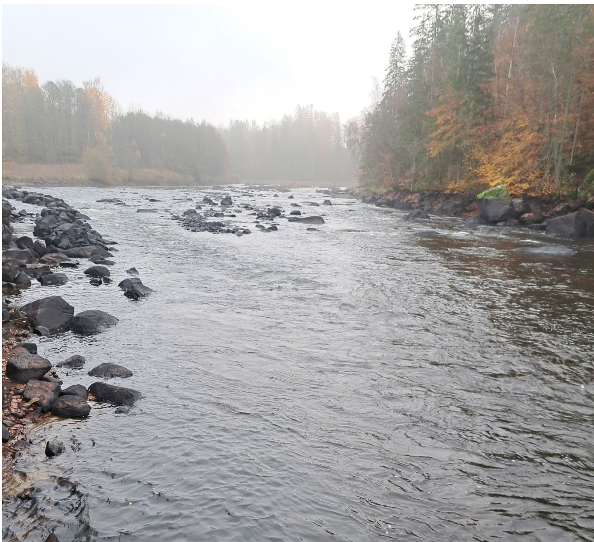
Figur 16. Ränna med stenarmar samt kvarvarande mer naturliga bottenförhållanden uppströms dammen. Obs foto taget vid lågt vattenstånd, betydligt lägre än dämningensgränsen.
