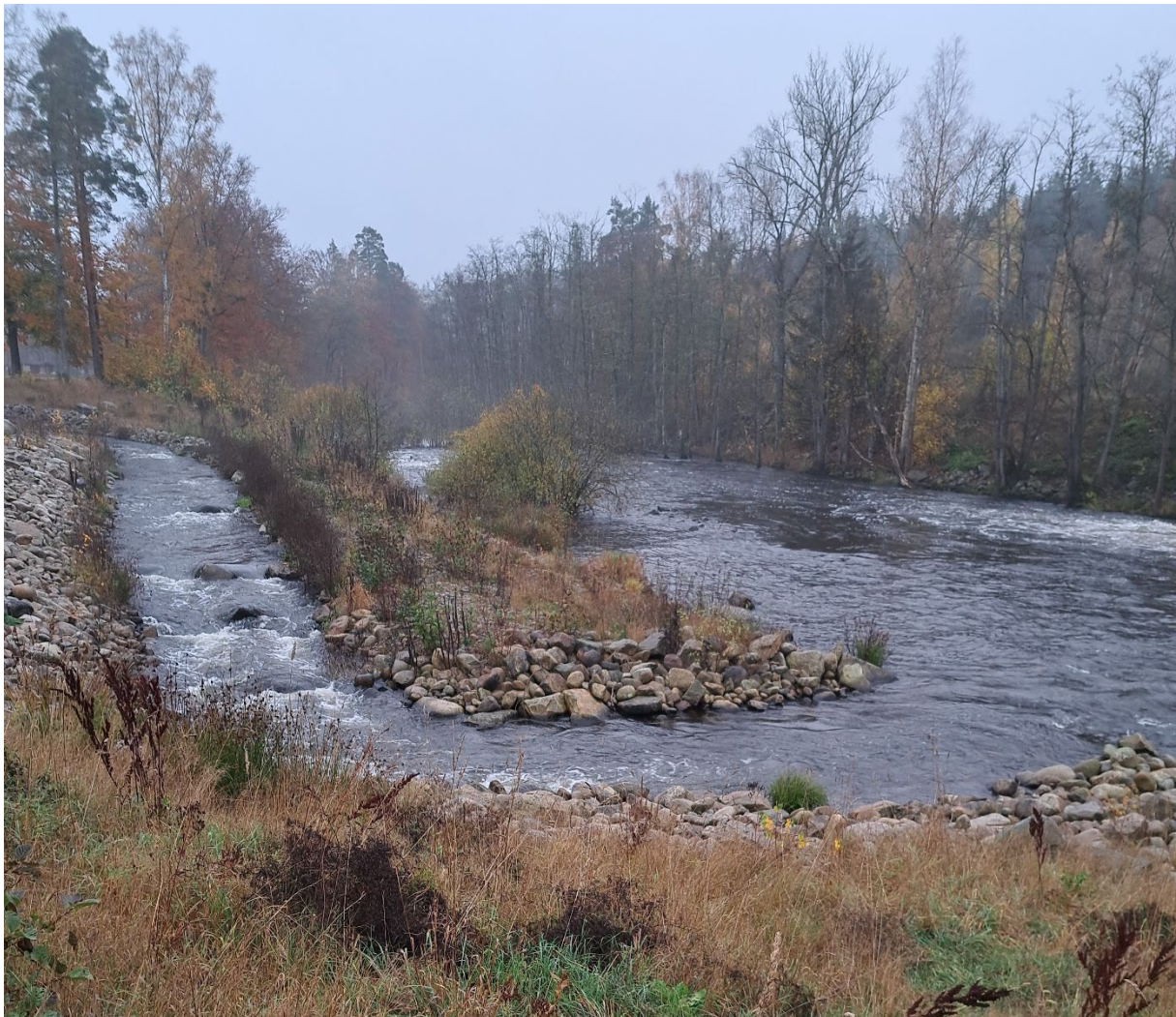
Figur 11. Fiskvägens mynning i naturfåran vid Fridafors nedre kraftverk
